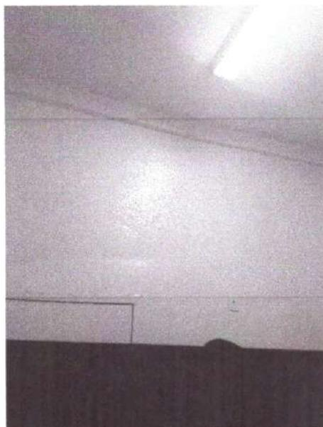
**Figura 14 - PAREDE FORA DO PRUMO**
